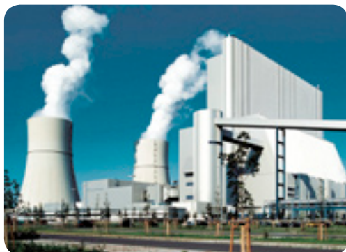
Kolkraftverket Schwarze Pumpe, Tyskland
