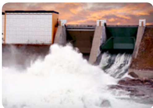
Porjus vattenkraftverk, Lule älv. Foto: Hans Blomberg
