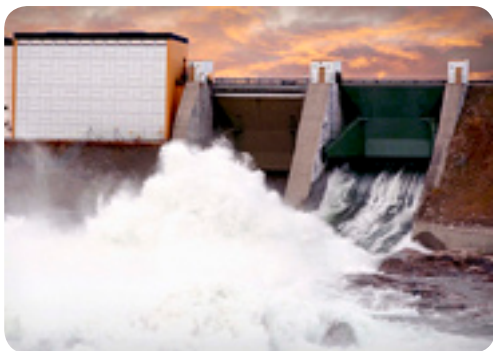
Porjus vattenkraftverk, Lule älv. Foto: Hans Blomberg
